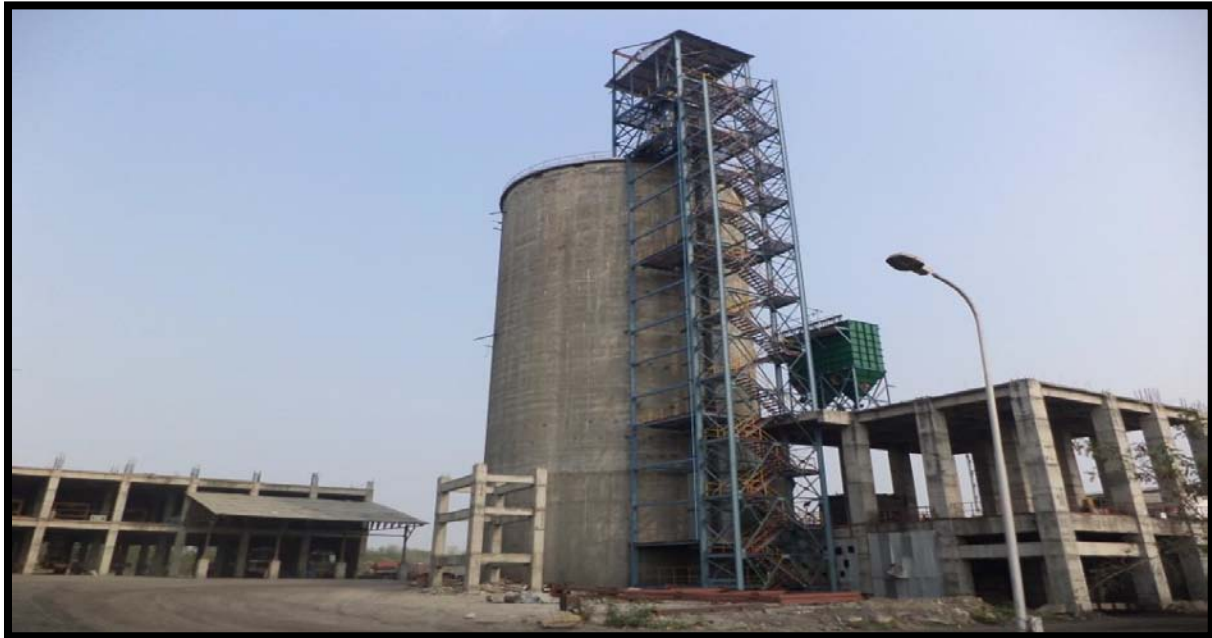
fly ash silo
